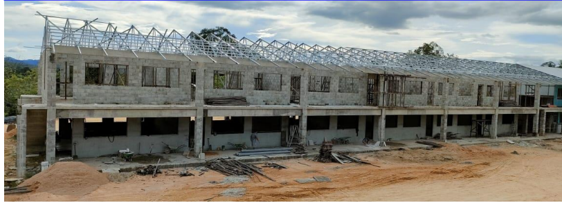
Boven: De muren van de tweede verdieping van de nieuwe middelbare school worden met de hand gevuld. Onder: Spanten gaan omhoog en dakplaten worden gemonteerd terwijl ik dit schrijf. Hopelijk hebben we dit gebouw klaar in juli.
