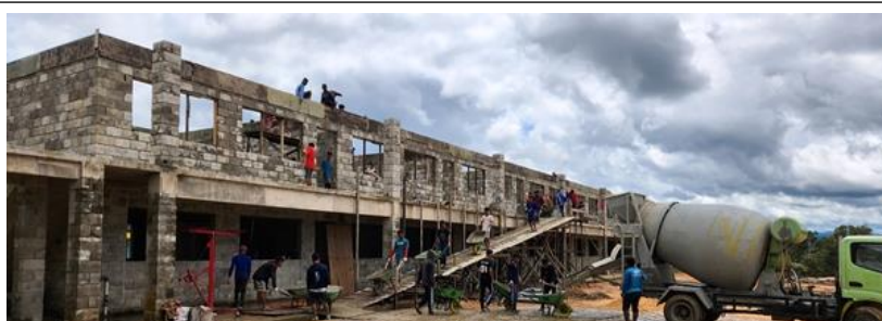
Boven: De muren van de tweede verdieping van de nieuwe middelbare school worden met de hand gevuld. Onder: Spanten gaan omhoog en dakplaten worden gemonteerd terwijl ik dit schrijf. Hopelijk hebben we dit gebouw klaar in juli.
