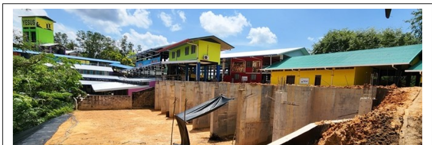
De massieve fundering en de eerste verdieping van ons Obed-gebouw zijn bijna voltooid. Nu klaar maken voor de tweede en derde verdieping.
